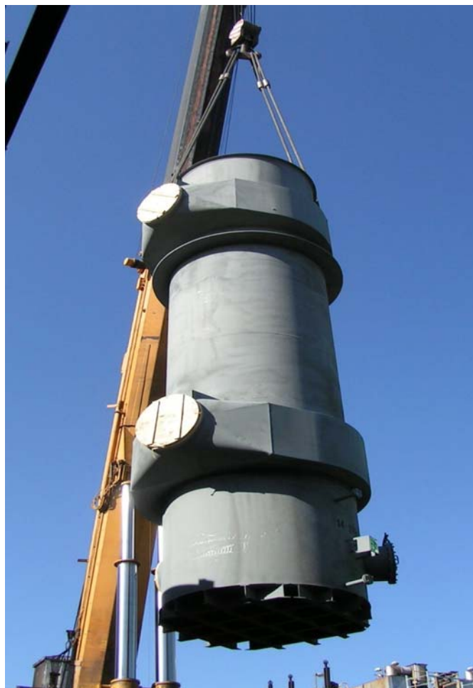
Obr. 15 Instalace rekuperačního výměníku
