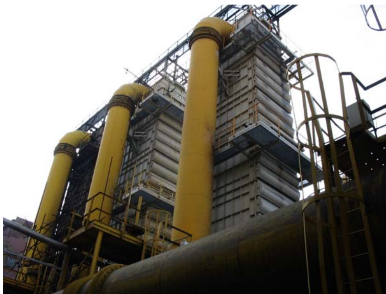
Obr. 1 Primární chladiče, Koksovna Svoboda, Ostrava
