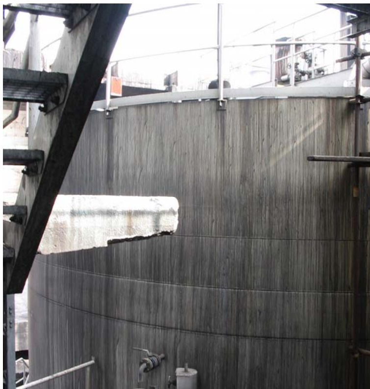
Obr. 5 Rozdělovač dehtových kondenzátů
