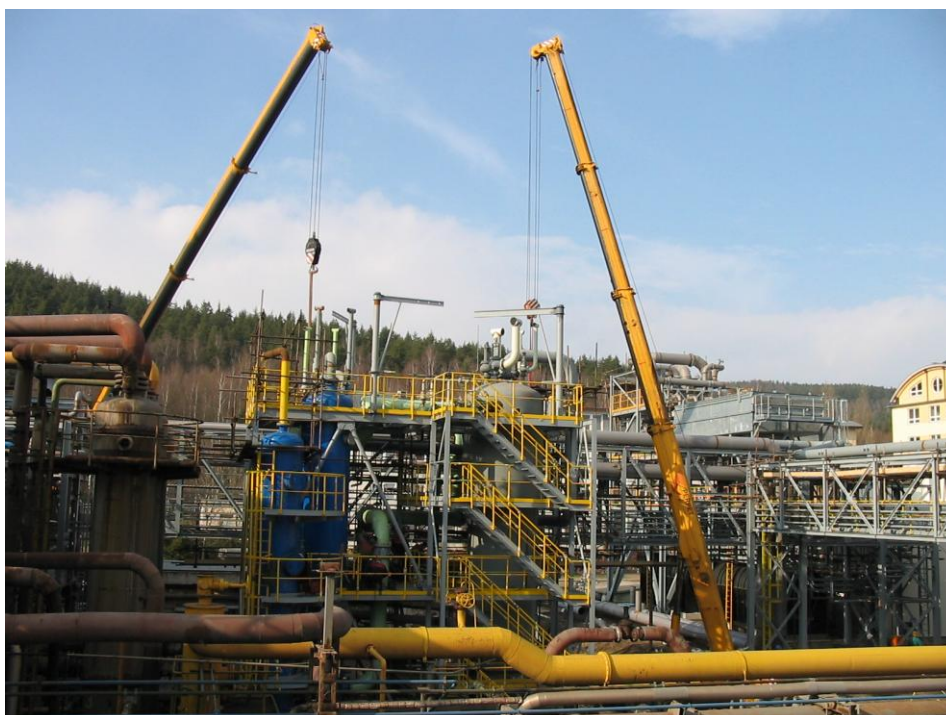
Рис. 8 Монтаж установки утилизации тепла
