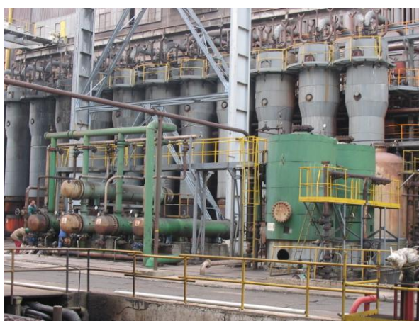
Рис. 1 – Установка паровых котлов-утилизаторов для охлаждения генераторного газа
