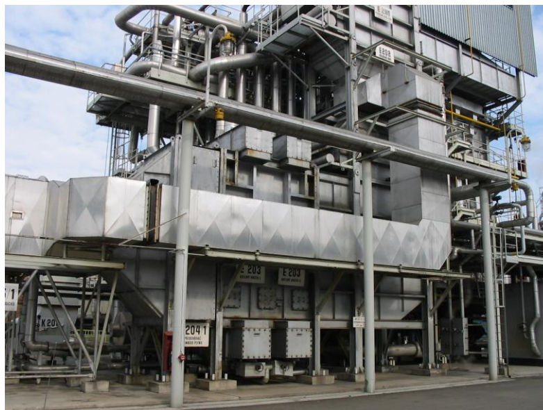
Рис. 9 Установка блока утилизации тепла
