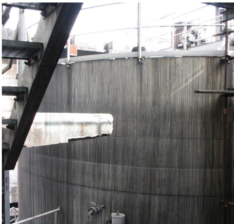
Рис. 5 Разделитель дегтевых конденсатов
