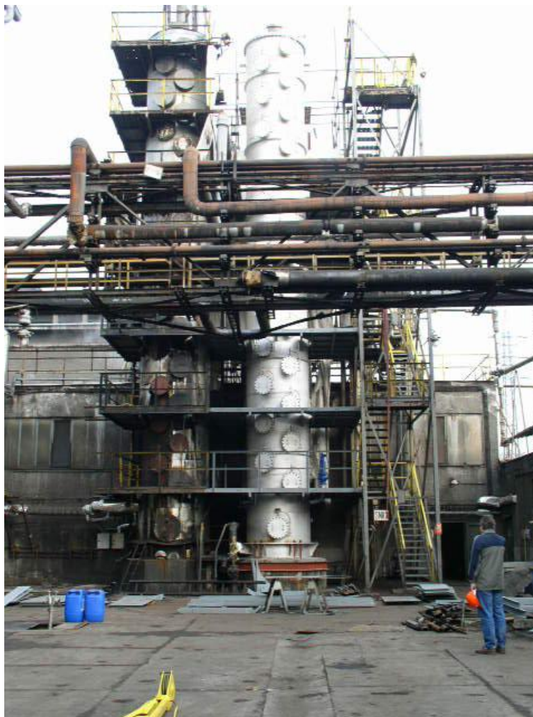
Рис. 9 Монтаж колонны отгона бензола, Коксовый завод Svoboda, Острава
