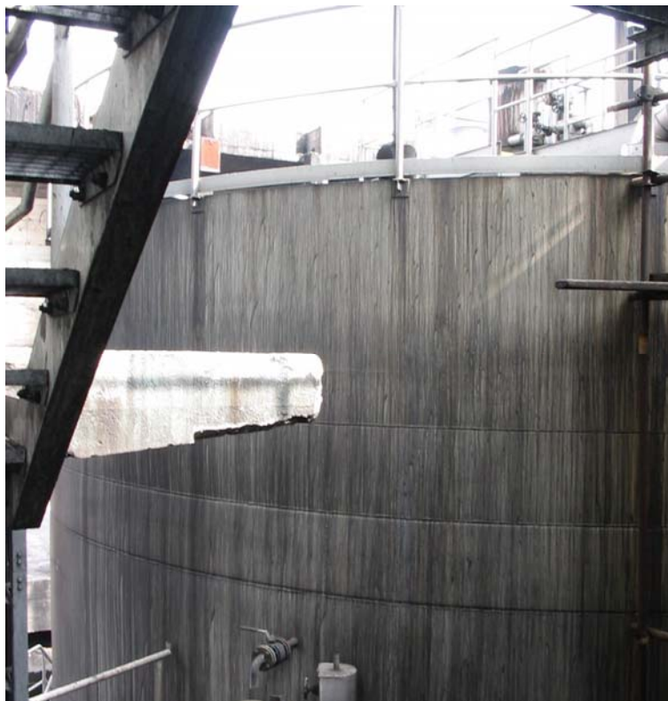
Fig. 5 Tar Condensate Separator
