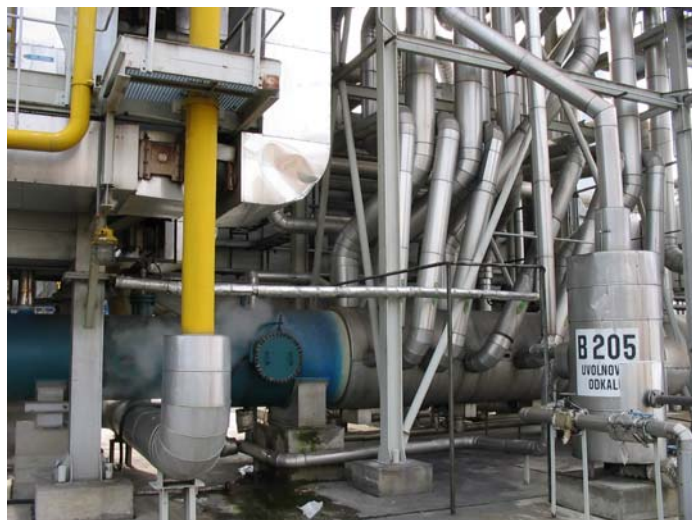
Obr. 5 Foto utilizačního kotle ve výrobě vodíku
